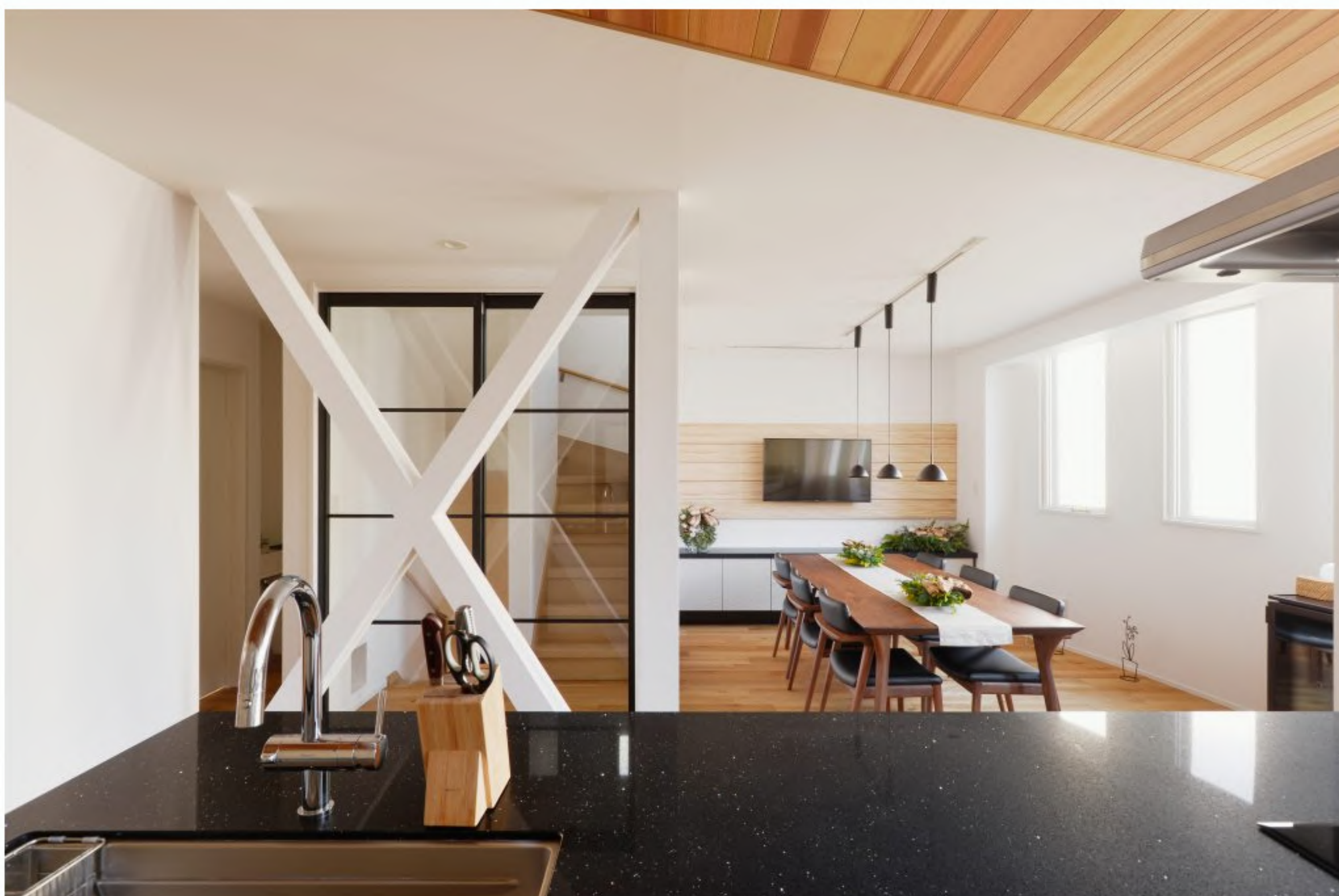
2Fリビングダイニングキッチン：大きな既存の筋交いも「男前」ないいアクセントに
