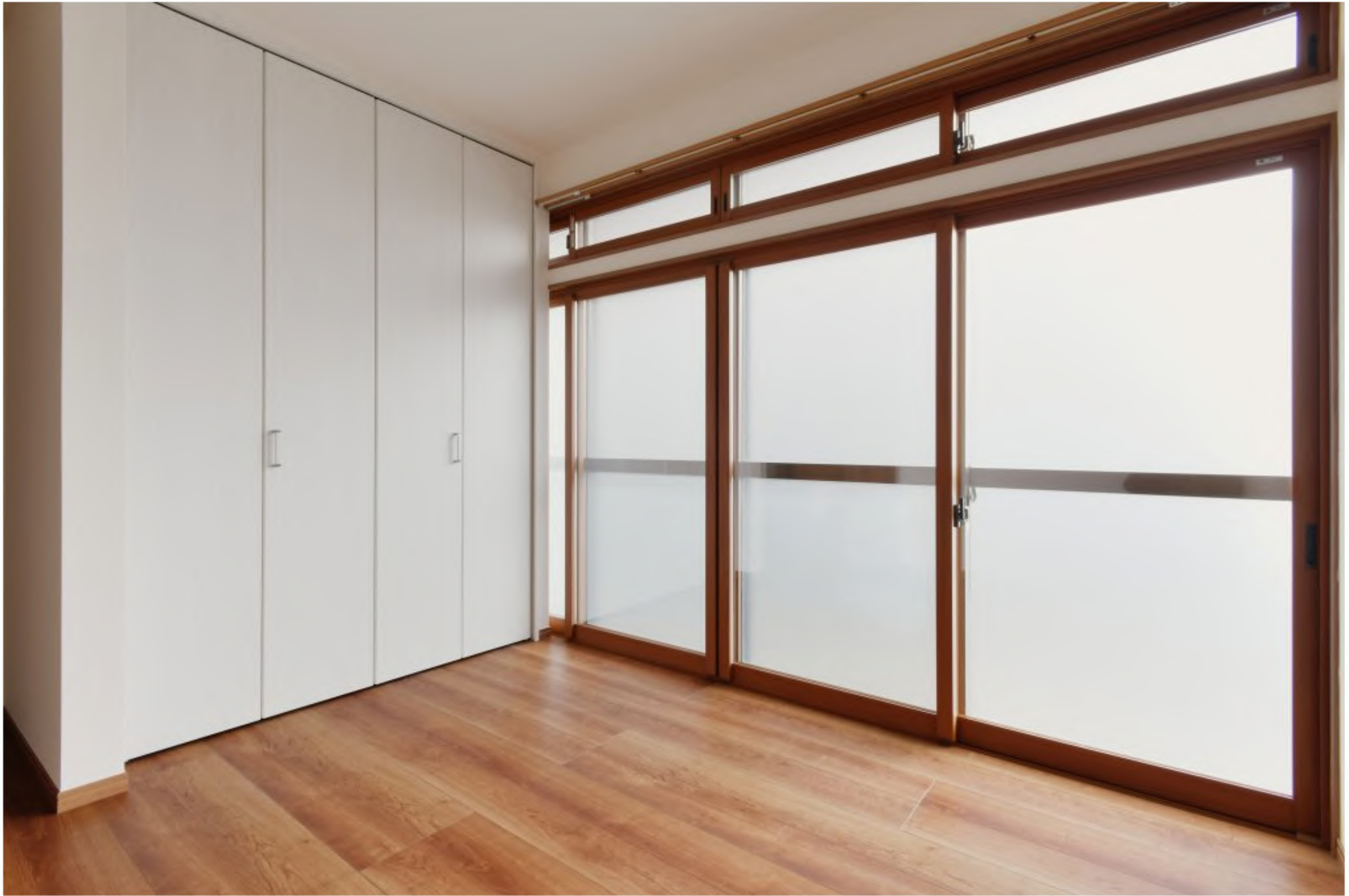
洋室1：元々あった大きな開口部は内窓を入れて断熱性を高めています
