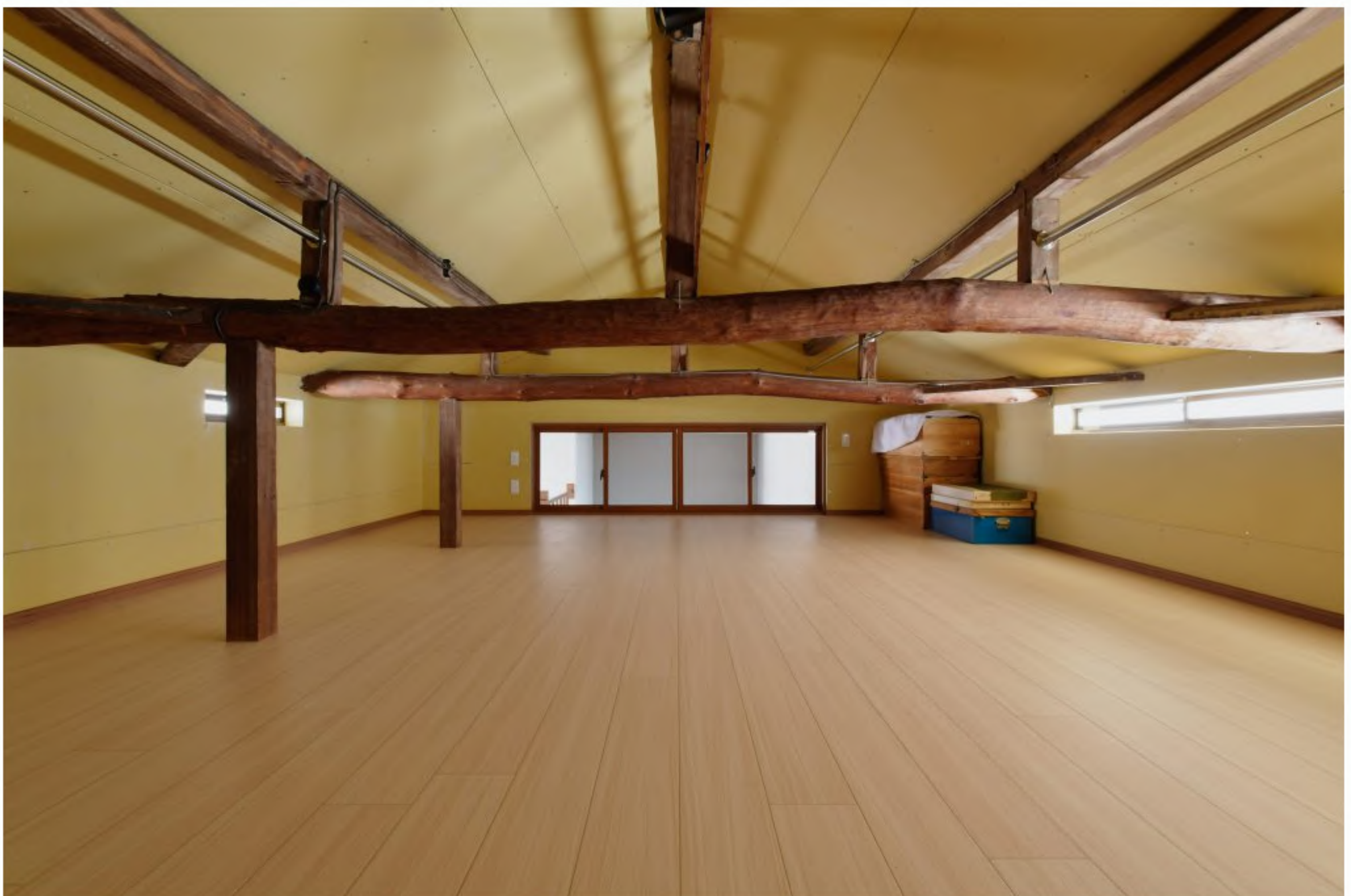
屋根裏：物置となっていた暑かった屋根裏も断熱を施し、部屋として使えるように。ここにもハンガーパイプを造りつけて使い勝手がいいように
