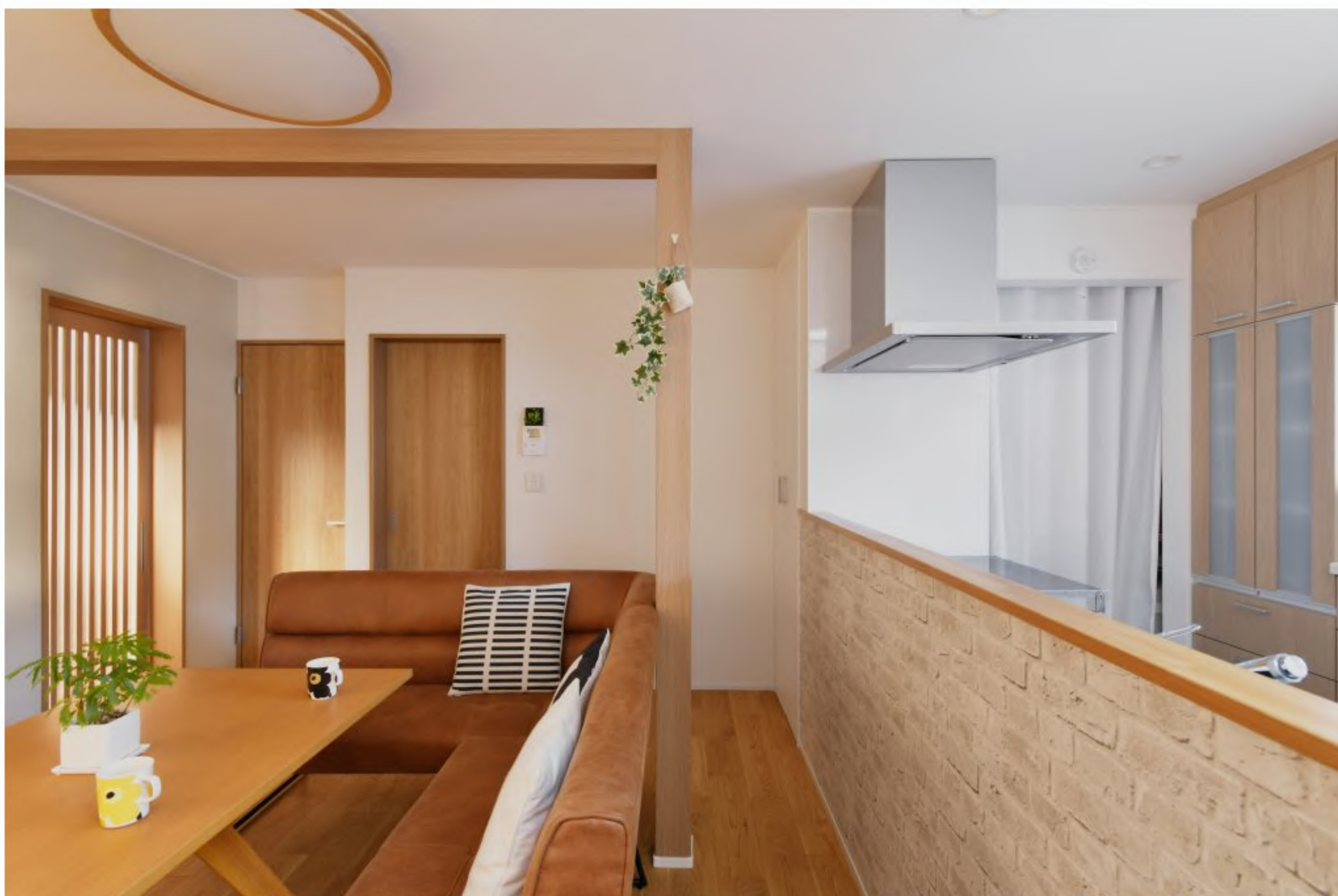
リビングダイニングキッチン：耐震上取れなかった梁と柱は木目のクロスを貼ってお部屋のワンポイントに
